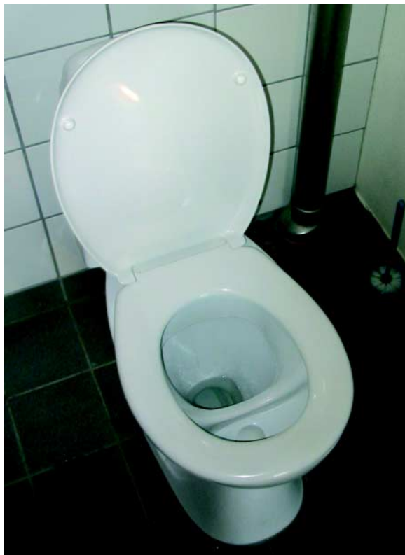
Munksøgårds urinsorterende toilet
